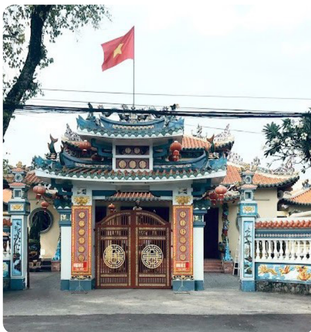
Hình 3.8. Đền thờ Nguyễn Trung Trực tại thành phố Rạch Giá
